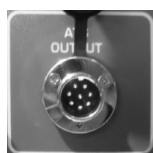
leșire ATS cu 8 pini pe panoul generatorului
